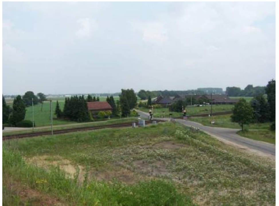
Passage Heierhoevenweg over overgang spoorlijn Eindhoven-Venlo
