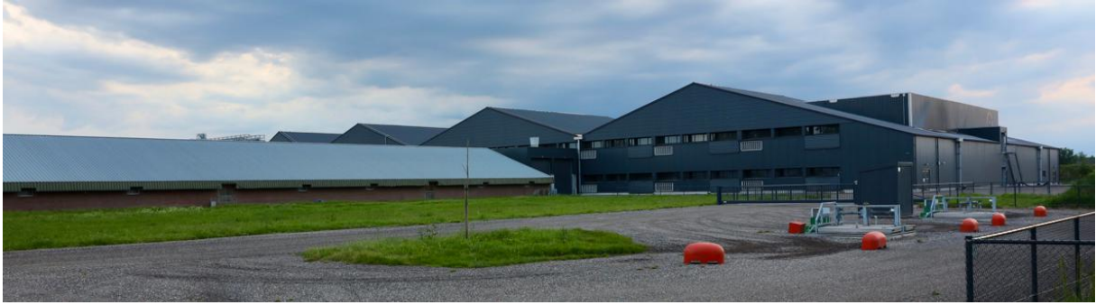
Aanzicht vleesvarkensstal NGB waar in 2 verdiepingen in totaal ca. 18000 varkens verblijven.
